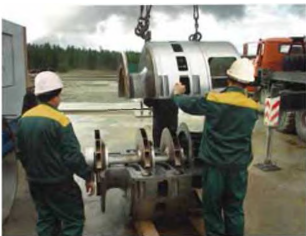
Сборка СПЧ на объекте
